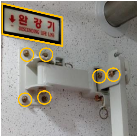
<설치 및 체결 상태 확인>
