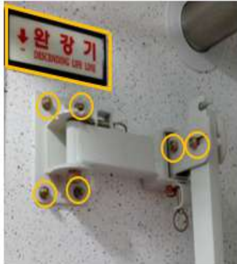
<설치 및 체결 상태 확인>
