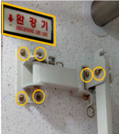
<설치 및 체결 상태 확인>
