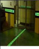
피난유도선  | ○ 광원점등방식의 배선을 지하층, 무창층의 작업장에서 피난로를 따라 설치<br>- 바닥으로부터 1m 이하에 설치                                     |
