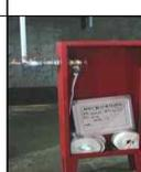
간이소화전<br>
