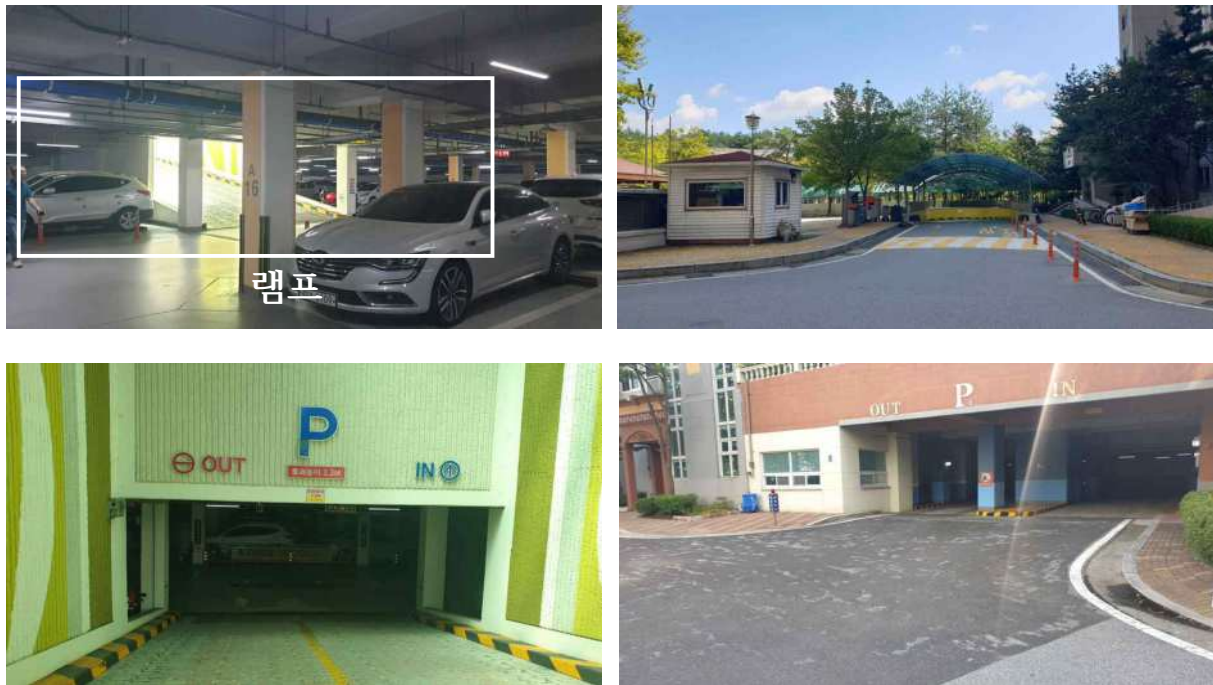
<그림 24> 램프 출구와 램프 입구모습
