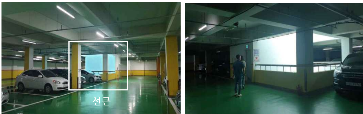
<그림 23> 선큰이 설치된 지하주차장
