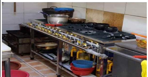
주방 내 화기 및 배관 교체 사진
