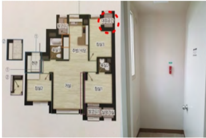
<대피공간 방화문 설치 >
