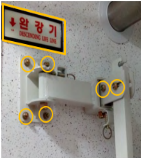
<설치 및 체결 상태 확인>
